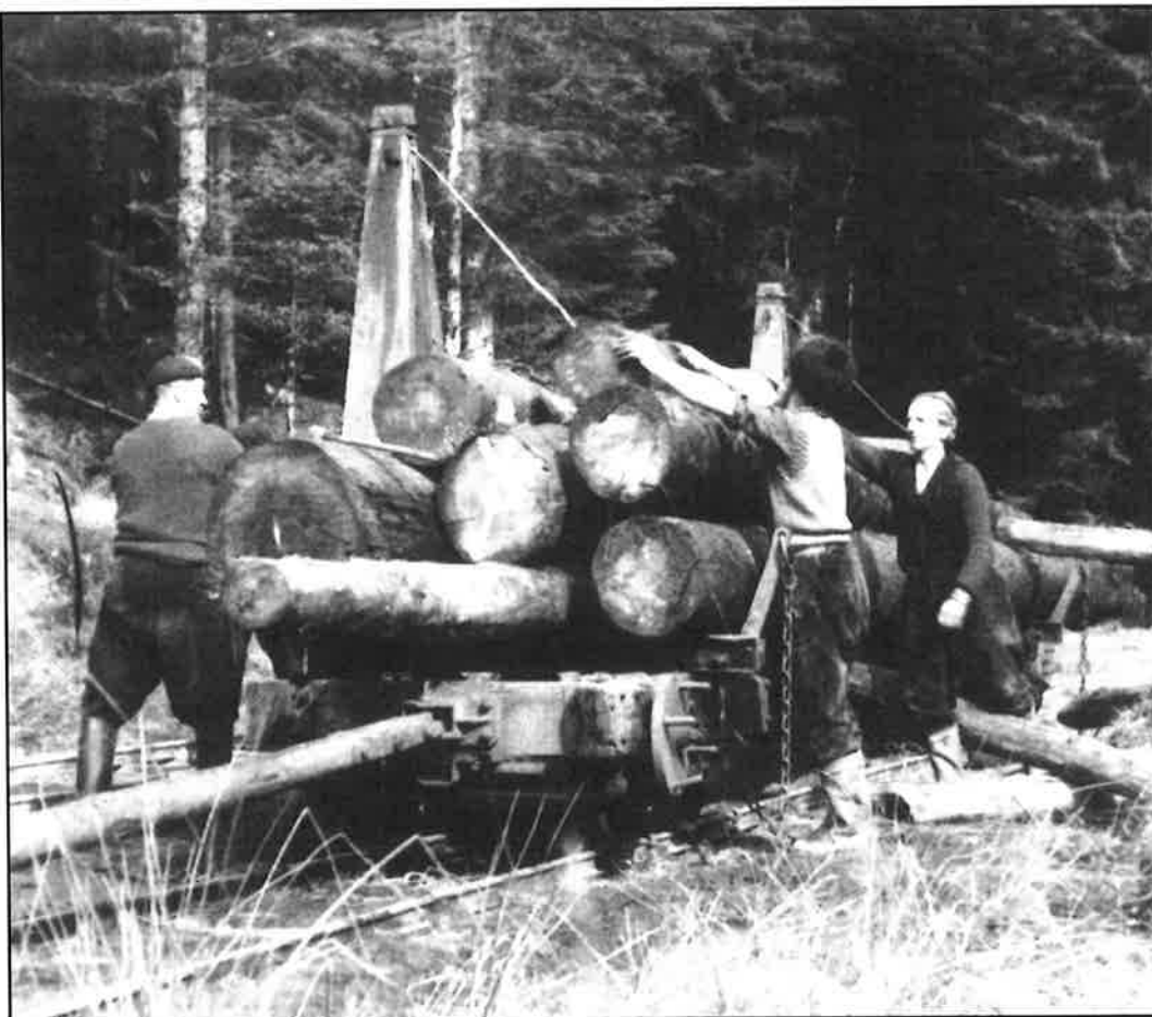
Chaque wagonnet était attelé au suivant et au précédent, ainsi qu'à la locomotive par une longue perche de bois frettée et munie d'un attelage à chaque extrémité. Ci-dessous : longue perche à l'attelage de la locomotive. Cette dernière "fait l'eau".
